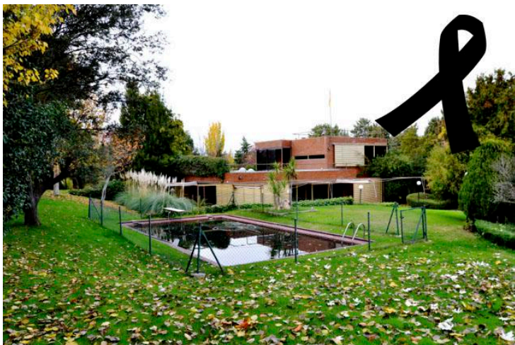
12. Vista sur de la Casa Guzmán antes de su demolición. Visita a la casa en 2014
